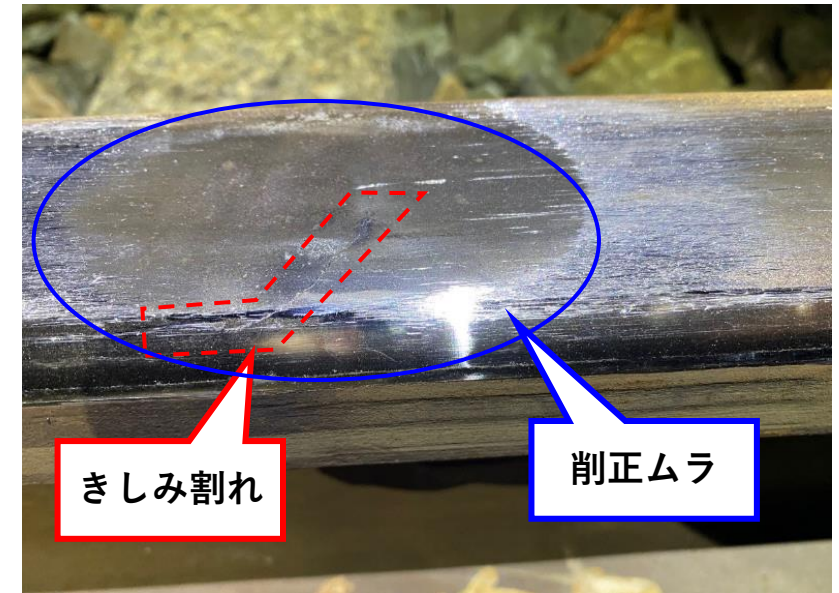
【きしみ割れ削正後の仕上がり】
