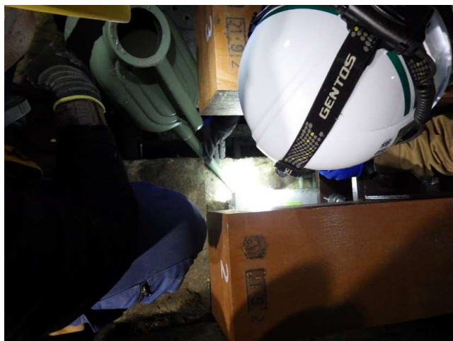
ジョウロを用いた打設状況
