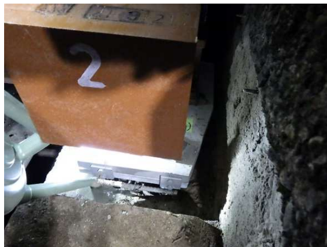
ジョウロを用いた打設状況
