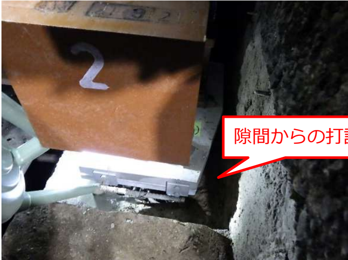
沓座モルタル打設状況
