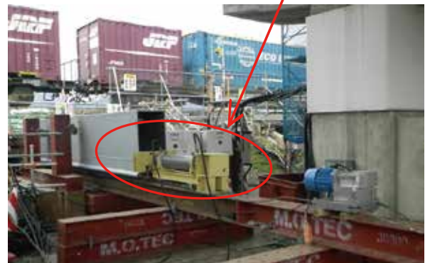
今回開発した 推進ジャッキと 可動式反力材
