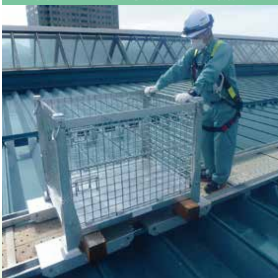
図1 運搬台車を使用した運搬状況
