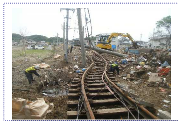
瓦礫の撤去状況(仙石線)
