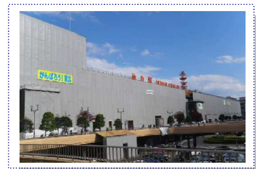
仙台駅復旧状況
